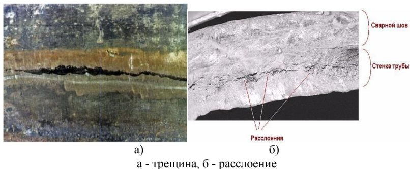
Рисунок 1 – Дефекты газопровода металлургического происхождения
